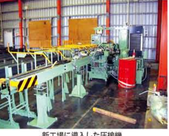
新工場に導入した圧接機
